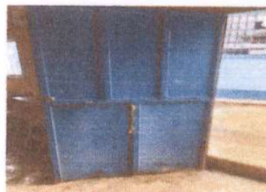
Fot 6. Puerta de aula número 2, oxidada, torcida, en mal estado Módulo 2, necesario cambiarla, medida 2.10*1mt.
